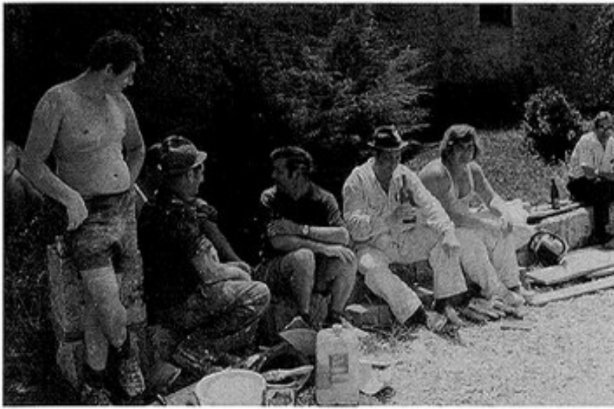
Die Kameraden beim Innenputzen.
