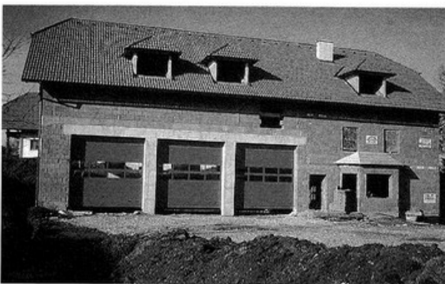
Der Rohbau unseres neuen Feuerwehrhauses
